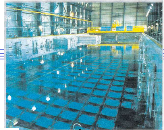
Kurzzeitzwischenlagerung Abklingbecken im KKW
